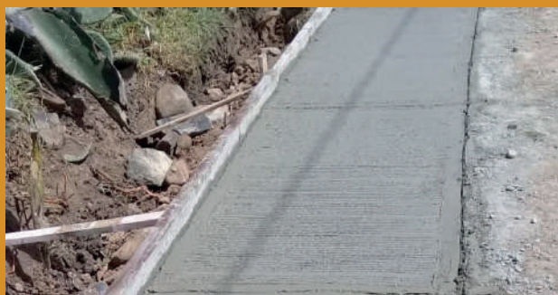
10. Construcción de rodadas, camino al Panteón. La Maqueda
