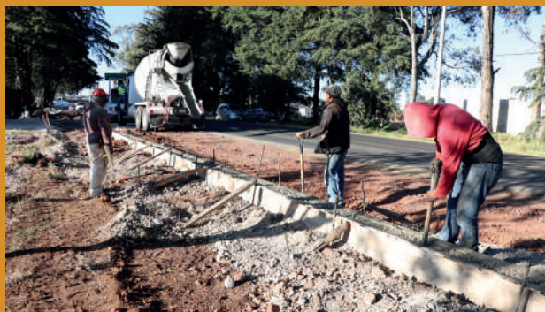
7. Construcción de guarniciones y banquetas (1ª etapa) El Fresno
