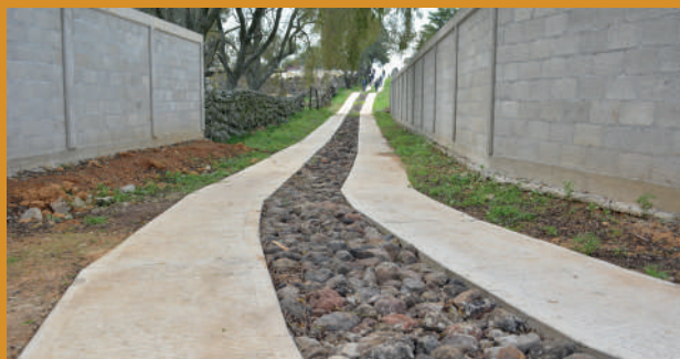
9. Construcción de rodadas y barda perimetral en El Manantial. El Majuay
