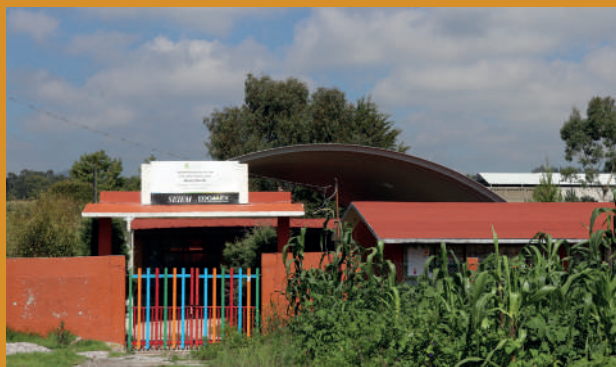
18. Construcción de techado en el Jardín de Niños “Huitzilihuitl” El Xhitey
