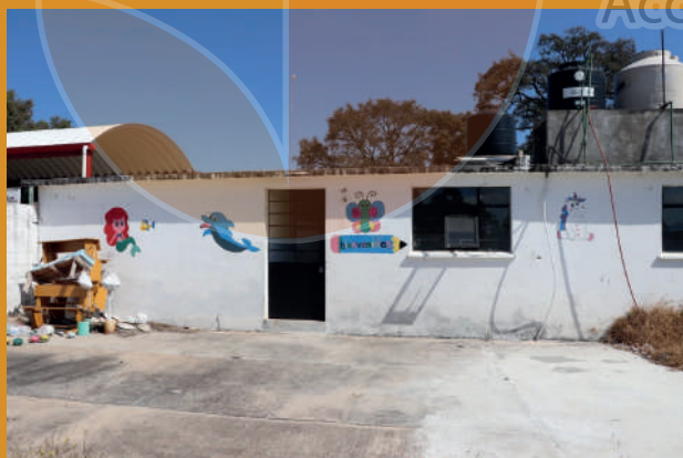
17. Rehabilitación de Escuela Inicial Ejido de San Lorenzo Octeyuco
