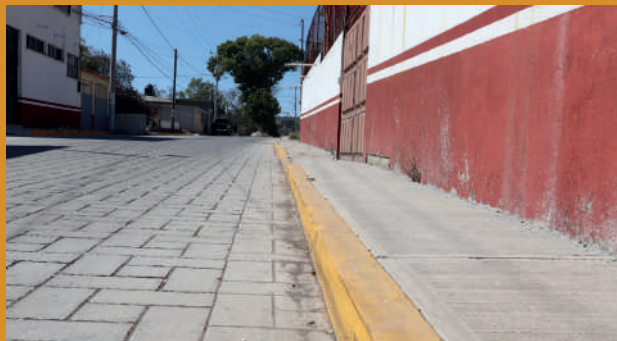
6. Construcción de guarniciones y banquetas en C. Andrés Quintana Roo. Col. El Deni
