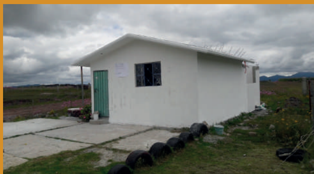
15. Construcción de losa en el Jardín de Niños “Niños Héroe de Chapultepec” (CONAFE) El Rincón
